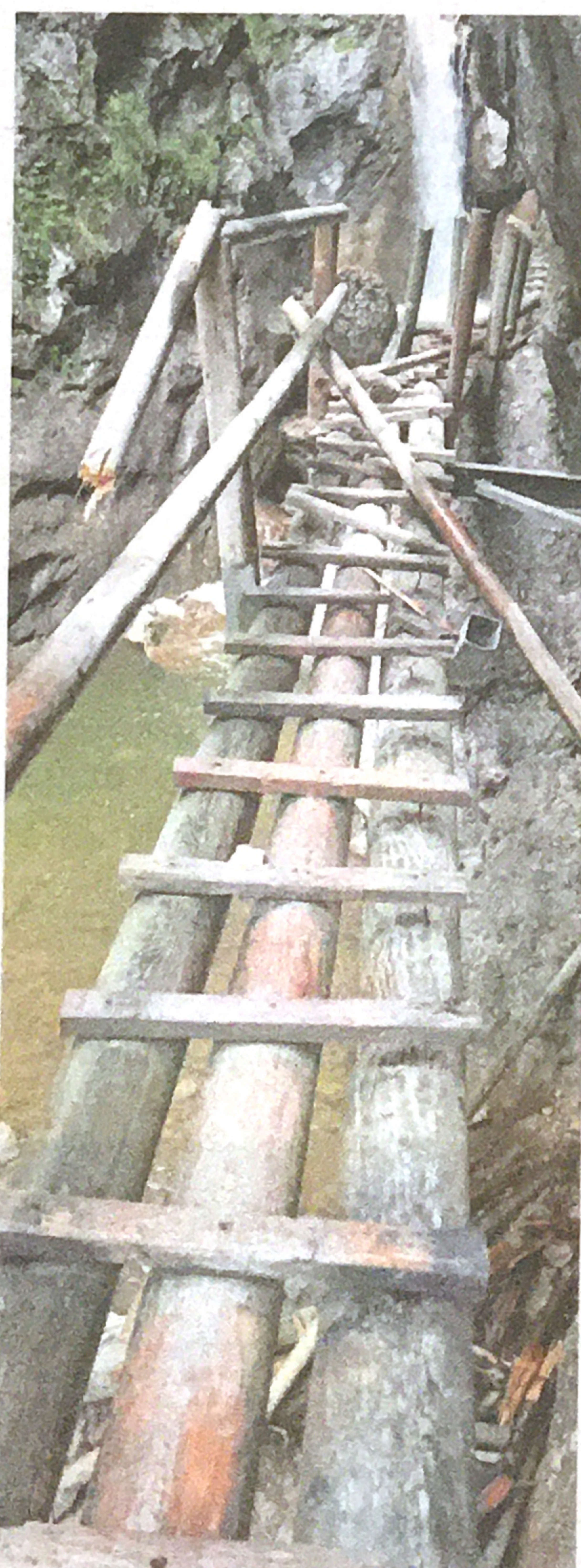
Steige und Brücken müssen neu errichtet werden APA/ÖAV SEKTION MIXNITZ
